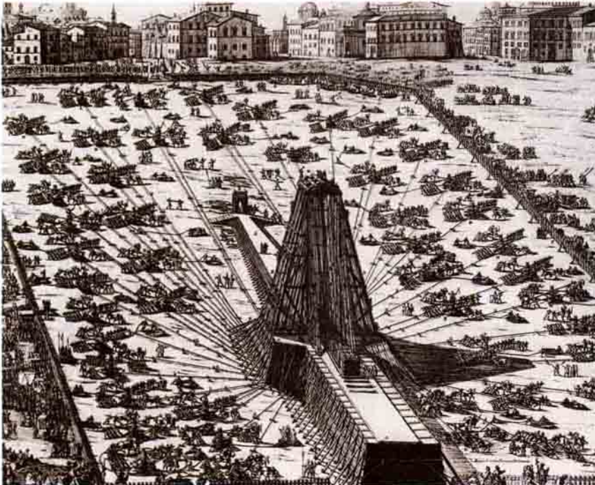
1586'da, obelisklerden birinin Papa'nın isteği üzerine Roma'da St. Peter Meydanı'na yeniden dikilmesi için, Fontana'nın projesini uygulamak üzere 26 metrelik bir ahşap kule inşa edilmiş ve 900 adam, 74 at, 13 km.lik 3 cm çapında halat ve 48 ırgat kullanılmış.
