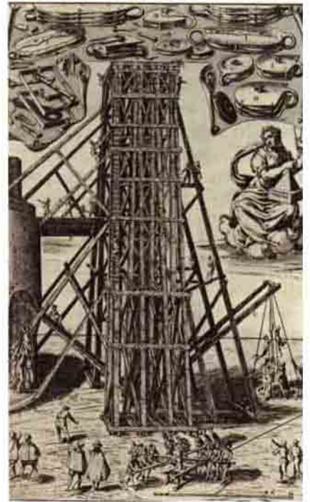
1586'da, obelisklerden birinin Papa'nın isteği üzerine Roma'da St. Peter Meydanı'na yeniden dikilmesi için, Fontana'nın projesini uygulamak üzere 26 metrelik bir ahşap kule inşa edilmiş ve 900 adam, 74 at, 13 km.lik 3 cm çapında halat ve 48 ırgat kullanılmış.
