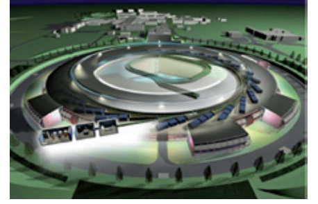
Diamond Işınım Kaynağı'nda parçacıkların doğrusal hızlandırıcıdan enerji öteleyici küçük halkaya geçişi, oradan da büyük halkaya yolculuğu ve bu halkadan elde edilen sinkrotron ışınının araştırmacıların kullanabilmesi için deney istasyonlarına taşınması (Üstte)
