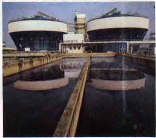
Benzerlerinin en modernlerinden olan Bayer Leverkusen'deki su arıtma tesisinden bir görünüş.
