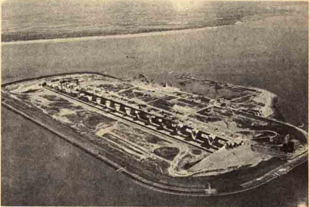
Su içinde büyüü bir halka : Haringuliet'te gelecekteki sulama bentleri için açılan inşaat çukuru. Bunun üzerinde 17 kapılı bir su seddi, eklüz yapılacaktır. Zemine çakılan beton kazıkların sayısı 22.000'dir.
