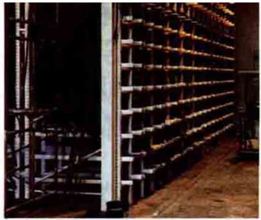
Elektromanyetik top için gerekli enerji, Florida'daki Eglin Hava Üssü'nde 14.000 eski araba aküsünün birleştirilmesi ile elde edilmiştir.
