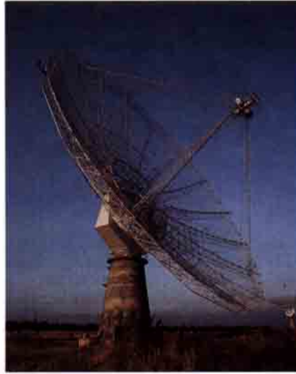
Hindistan'daki Büyük Metredalga Radyo Teleskopu, herbiri 45 metre çapında toplam 30 çanak antenden oluşan bir sistemdir. Bu sistem, gökadalara ve yıldız kümelerini oluşturan devasa hidrojen bulutlarının incelenmesinde kullanılıyor.
