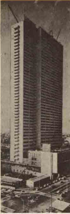
47 katlı, 170 m. yükseklikteki Tokyo'nun Keio Plaza Otelinin inşaatı sadece iki yıl içerisinde tamamlanmıştır.
