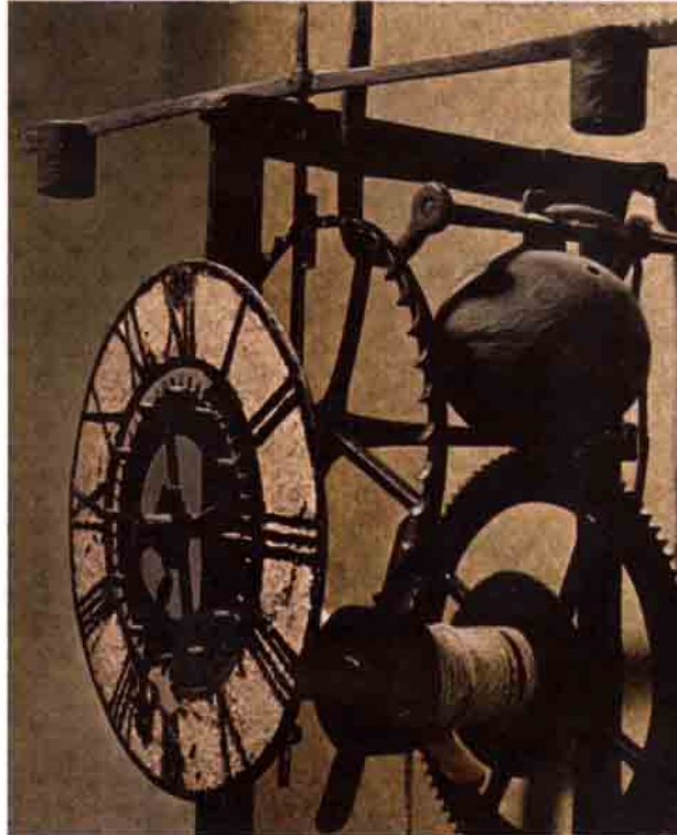
Ağırlıkla çalışan ilk mekanik saatlerden. Kısa aralıklarla duran ve inen ağırlık, saat mekanizmasını günün uzunluğuna ya da kısalığına bağlı olmaktan kurtarıyor.
