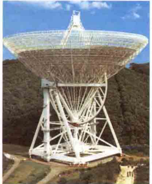
Şekil 3: Çanak antenli bir radyo teleskop. Bonn Max Planck Radyo-Astronomi Enstitüsü'ne ait olan bu teleskopun çapı 100 m toplam metal kütleli 3200 tondur. Solda kontrol yapısı göze çarpıyor.
