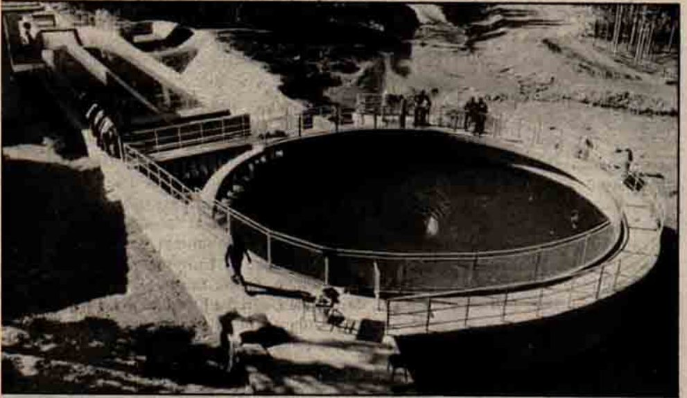
Resim 5— Dairesel Çökeltme havuzu (Sızır hidroelektrik tesisleri)
