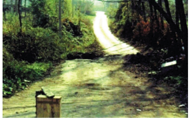
Şekil 3. Hacıyakup yakınlarında fay boyunca ana yolun 2m'lik düşey atımı ve Kaynaşlı'da fayın 2.5 m'lik doğrultu atımı gösterilmektedir. Burada 40 cm'lik düşey atımda görülmektedir.
