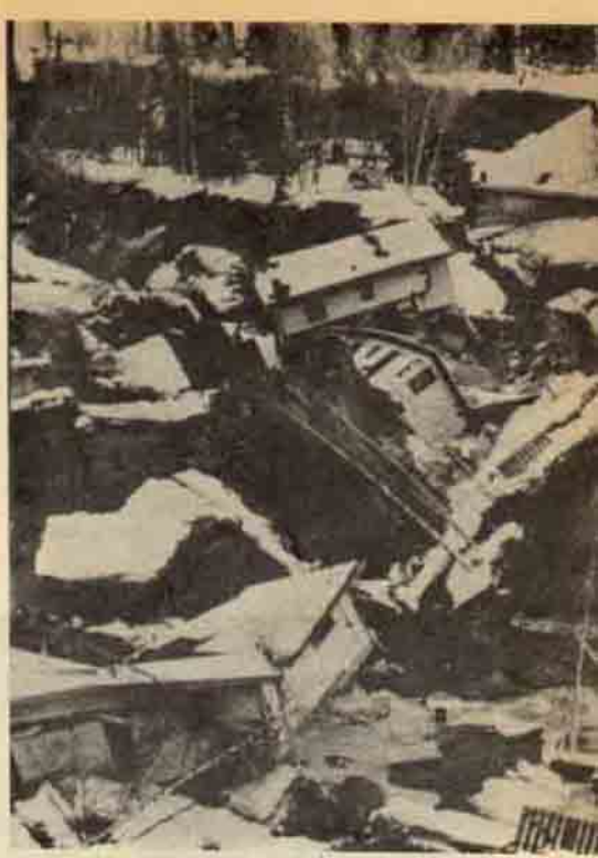
1964 Alaska depreminde harap olan Anchorage'deki evler
