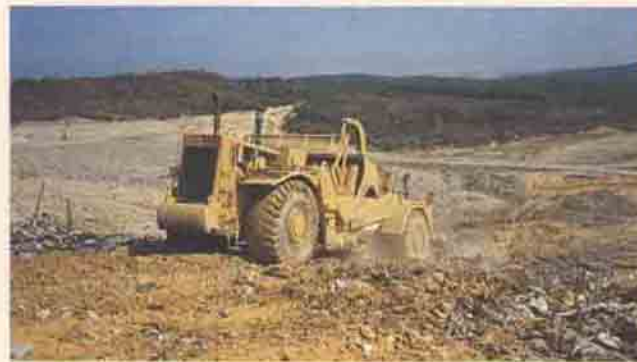
Çöp alanlarında günlük örtü uygulaması, külle örtme de benzer bir yöntemle uygulanıyor.
