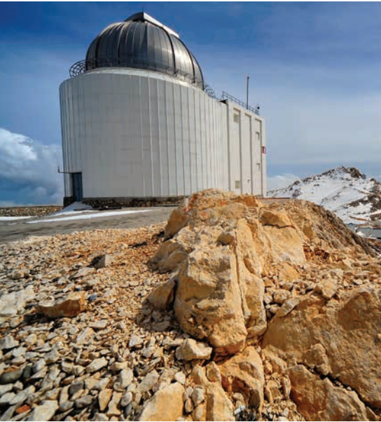
RTT150 teleskop binası
