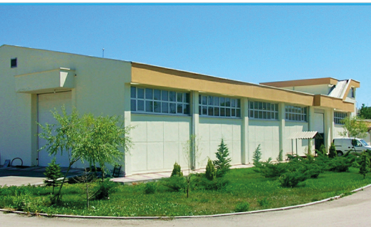
TAEK Gama Işınlama Tesisi
