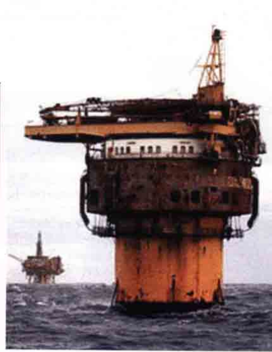
Brent Petrol Havza'sındaki platform zincirinin bir halkası olan Brent Spar, terk edildiği 1992 yılına kadar petrol depolama ve dağıtım istasyonu olarak kullanılmış.
