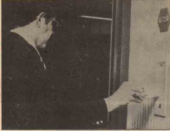
Özel yarığa sokulan kart otomatik olarak kapıyı açar.
