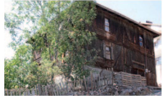
Çamlıdere ve Pelitçik'te tamamen ahşap karkas ve ahşap kaplama evlere (üçüncü tip) de rastlanmakta ve Karadeniz ev tipolojilerini ve biçimlerini anımsatan bu evler insanî şaşkınlığa sürüklemektedir.
