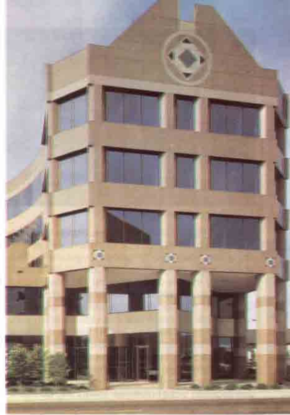
ABD'de enerji-etkin olarak tasarlanmış ve yapılmış bir banka binası. Bu binada kullanılan pencereler bankaya ısıtma sistemlerinden 59.000 $ kazandırmıştır.
