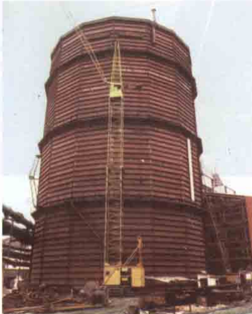
Levha bükme makinesi kullanılarak inşa edilen gaz deposu (30 m çapında, 52 m yüksekliğinde).
