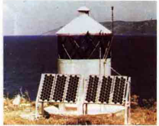
Uzak kıyı şeritlerinde ve denizde: ABD'de daha şimdiden on bir bin fener güneş enerjisiyle işlemektedir. Güneş hücreleri gündüz pilleri yüklemekte, piller de gece projektörlere akım sağlamaktadır.
