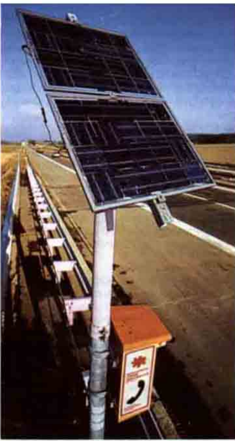
Otoyollar üzerinde: Güneş enerjisiyle çalışan bu acil çağrı telefon kulübesi, Schwäbische Alb'deki bir federal yolun üzerinde bulunmaktadır.
