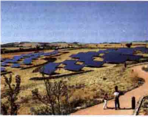
Koblenz'teki bir bağa yerleştirilmiş olan sekizbin güneş panosu, ikibin aileye akım sağlamaktadır.
