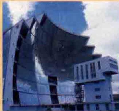
Fransa'daki "Güneş fırını" Odeille. Dev parabol aynalarla güneş ışınları yakulamaktan sonra, yoğunlaştırılarak sinanan malzemenin üzerine odaklanıyor. Böylelikle metrekareye 10 milyon watt enerji düşüyor.
