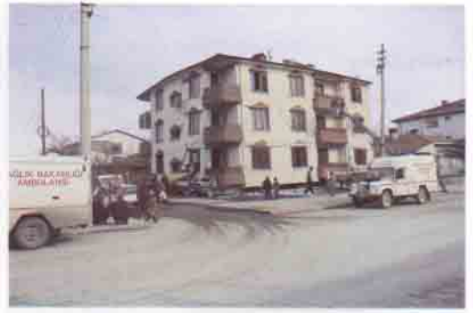
Üst katları dolgulu, alt katı ise dolgunsuz (yumuşak) betonarme çerçeveli bir binanın deprem öncesi ve deprem sonrası durumu. Depremde alt kat anı çökmeye uğramış, üst katlar adeta bir kat aşağıya düşmüş.
