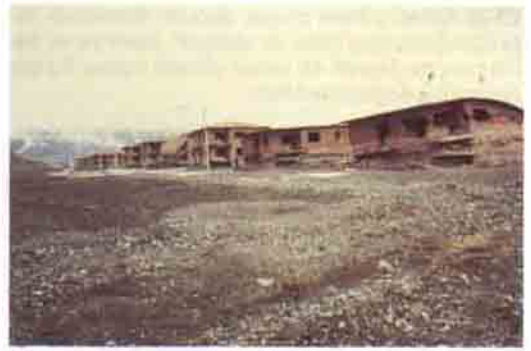
Üzümlü kasabası girişinde zayıf yığma binalardaki hasarın kuzeydeki tepeler yönünde hızla azalması.
