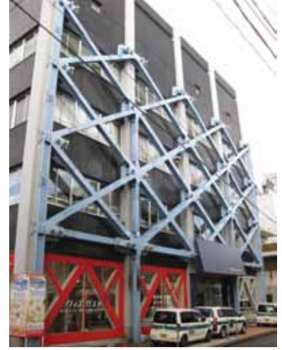
Şekil 6. Yapı güçlendirmesi
