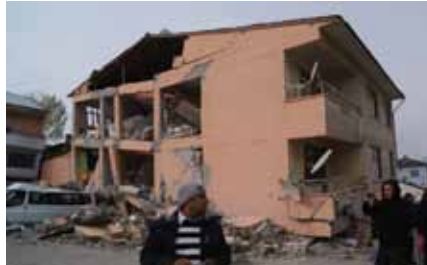
Şekil 2. Kat göçmesi
