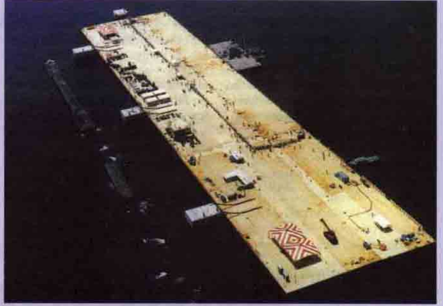
Tokyo Körfezi'ndeki "Yüzen-Dev" adlı deneysel platform 300 m boyunda, 60 m eninde ve 3 m yüksekliğindedir. Bu teknolojinin, havaalanı olarak kullanılması düşünülüyor. Ayrıca platformlar üzerinden roket fırlatma çalışmaları yapılıyor.
