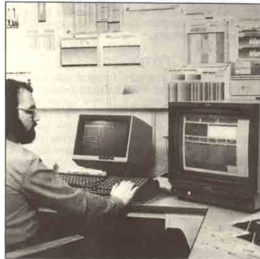
Fotoğrafta bir fotodizgi ünitesinin klavye ve ekran terminali görülmektedir. Fotodizgi sisteminde kurşun harflerdeki fiziksel kısıtlamalardan kalkan, Harfler istendiği gibi espaslanabilir, hatta üstüste bindirilebilir.
