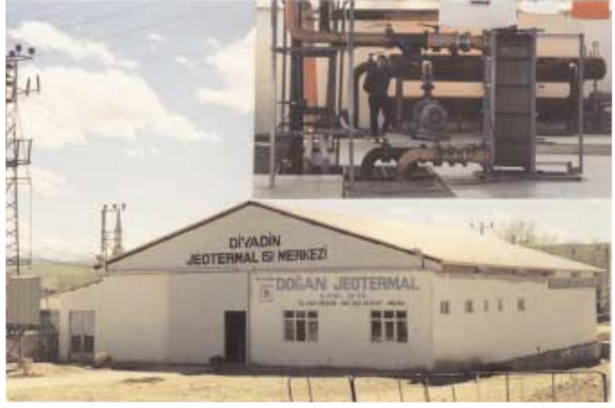
Diyardin jeotermal ısı dağıtım merkezi.
