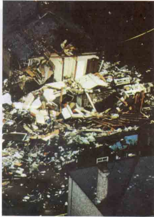
Patlama sonucu oluşmuş enkaz.
