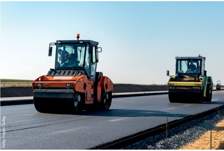
Asfalt yol yapımı
