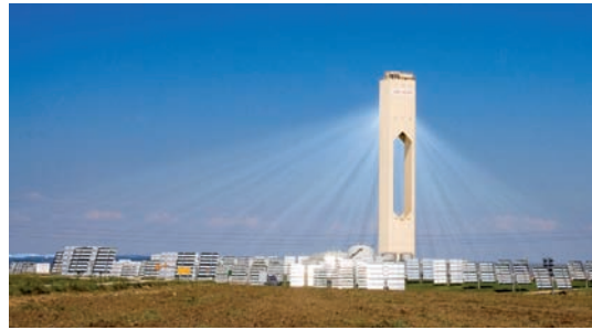
Andasol 1, İspanyada kurulan, heliostatlı (ayna tarlalı) 50 MW'lık güç üretim tesisi.
