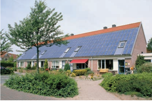
Şebekeden bağımsız PV güç sistemi
