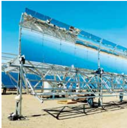
Parabolik aynalarla elde edilen su buharı türbinleri döndürür.
